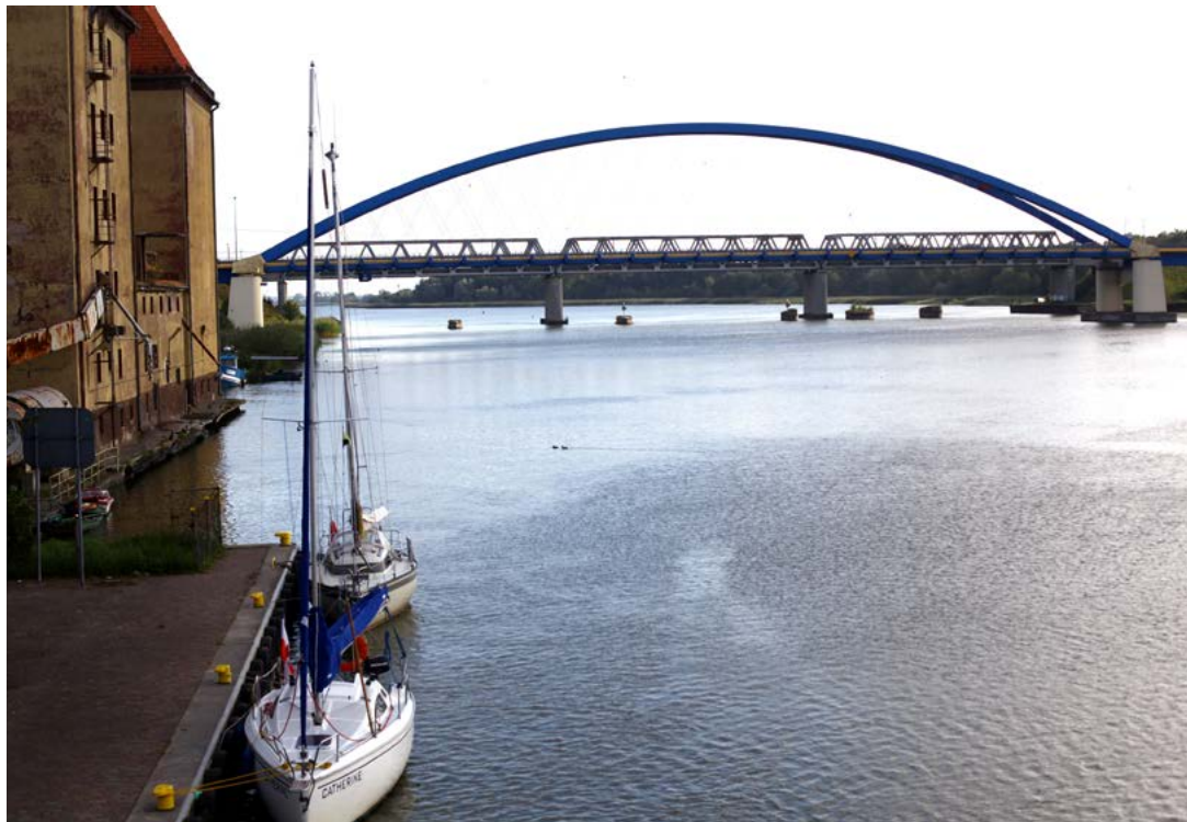
Mosty na Dziwnie – drogowy i kolejowy. Wolin, 2017 r. FOT. ARTUR KUBASIK
